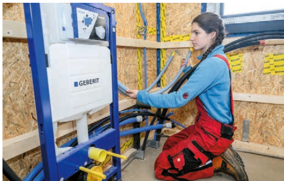
^ L'apprentie pose les conduites de distribution d'eau vers les étages d'une maison en construction.
