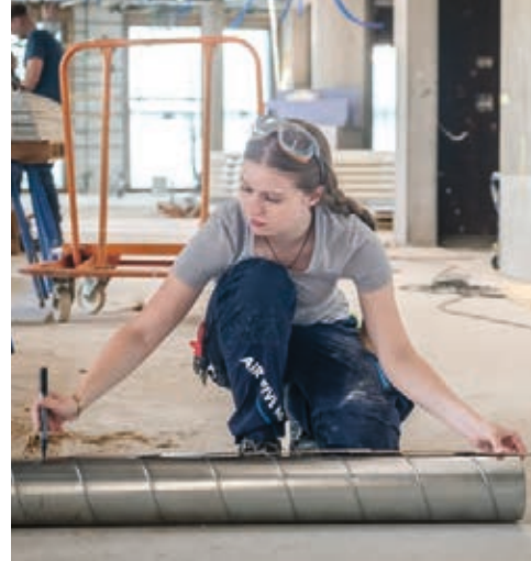
^ L'apprentie reporte soigneusement les mesures sur un conduit, en vue de le découper aux bonnes dimensions.
